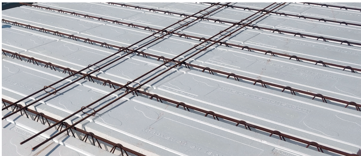
Mise en œuvre de COFFRABOX PT
