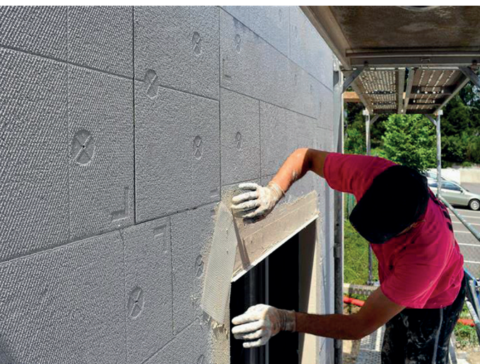
Mise en œuvre des panneaux KNAUF ETIXX ici avec un point singulier angle de baie de fenêtre.
