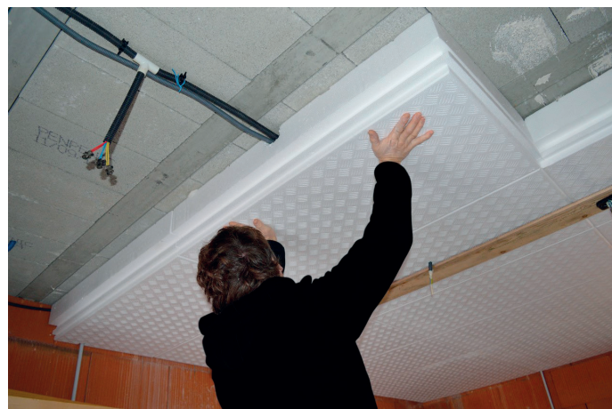
Mise en œuvre de DECobox 36
